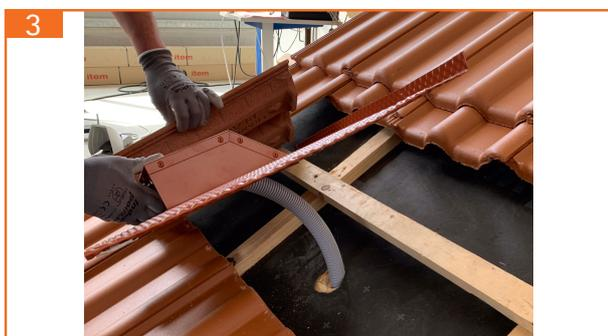
3. Leerrohr einsetzen, bei Bedarf abdichten
