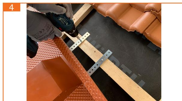
4. KD-PV ausrichten und mit Dachlattung verschrauben
