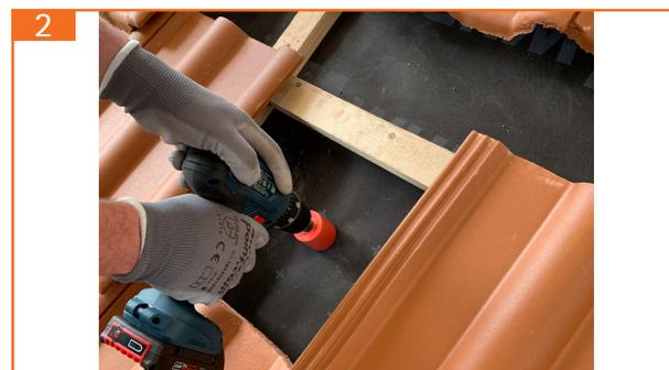
2. Öffnung DN32 mit Lochsäge/-fräse für die Kabeldurchführung schaffen
