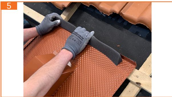
5. Schutzfolie des Kehldichtstreifens (500 mm) abziehen und auf der oberen Kante anbringen.
