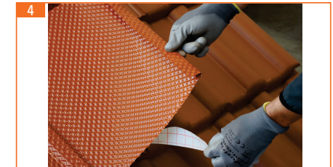
4. Schutzfolie des Butylklebestreifens abziehen.
