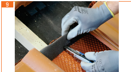
9. Kehldichtstreifen an Dachhakenposition L-förmig einschneiden.
