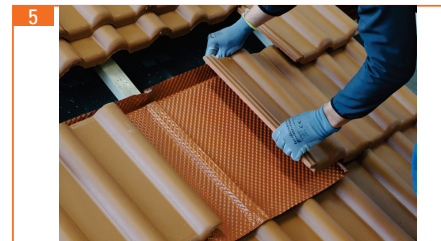
5. geba PV flex andere Seite eindecken.
