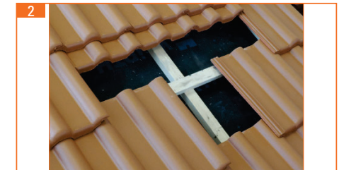
2. Originaldachziegel entnehmen
