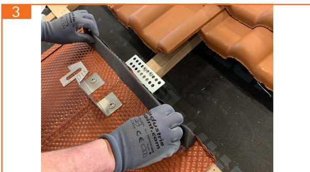
3. Schutzfolie des Kehldichtstreifens (500 mm) abziehen und Kehldichtstreifen bündig zur Oberkante anbringen.
